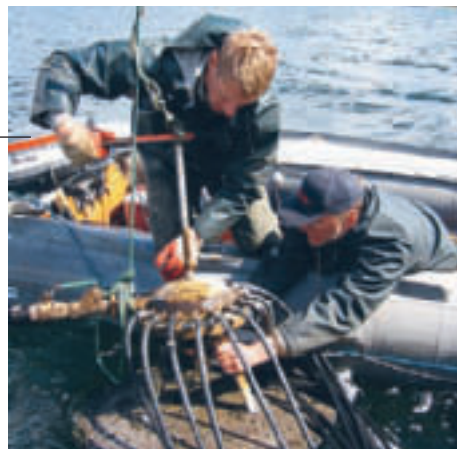
Så kallade diffusorer placeras på botten av sjön och släpper ut syre nära botten.
